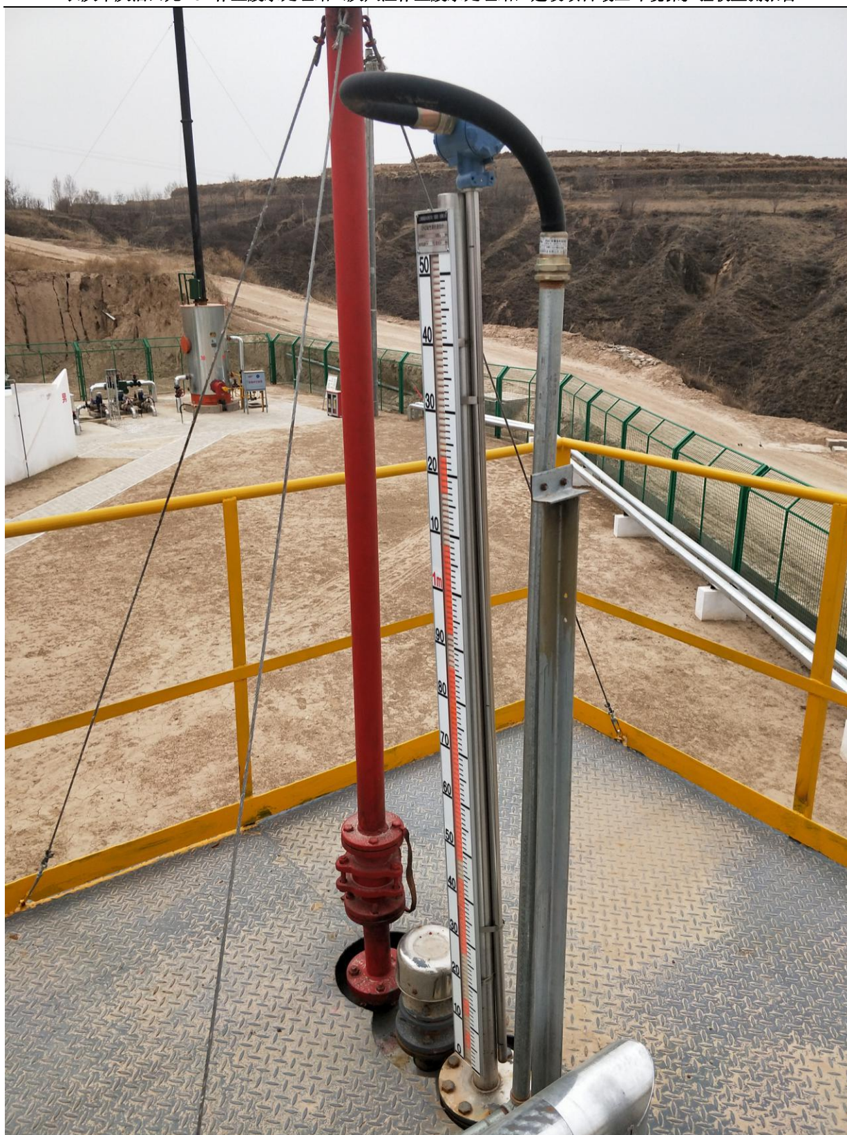
图 4-5 卸车气相平衡及液位计
