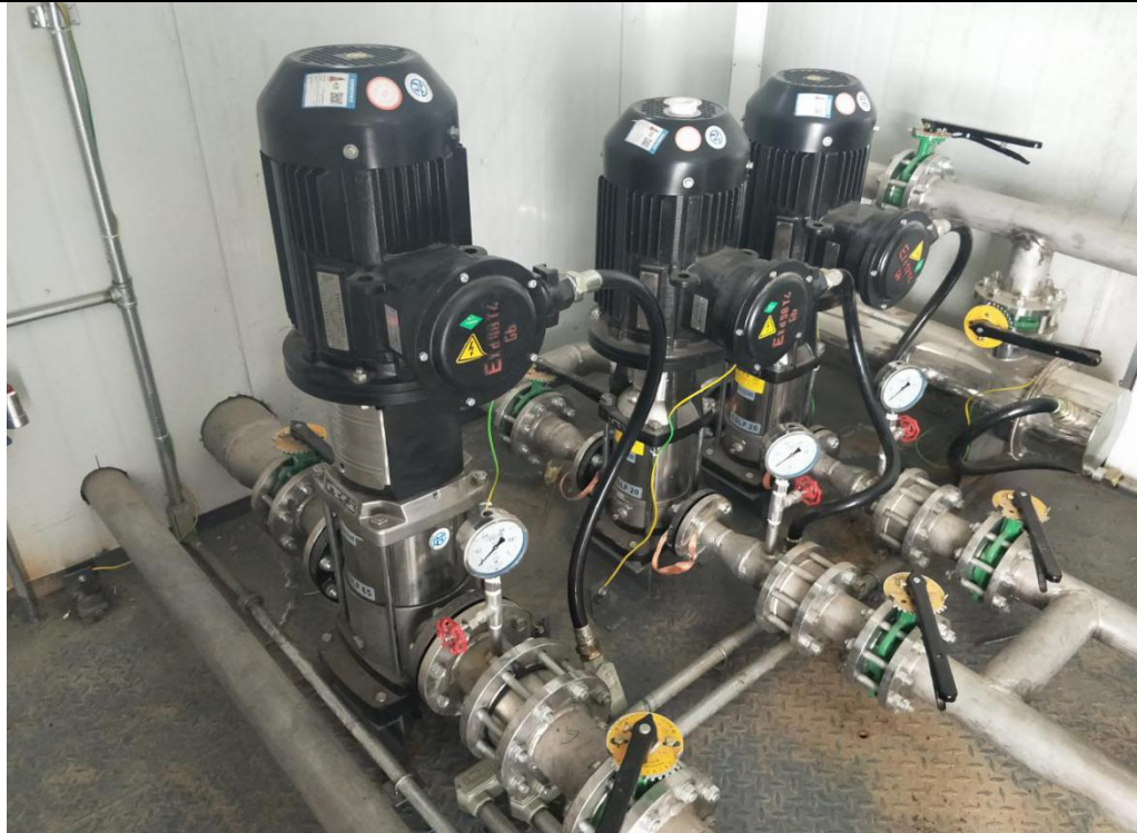
图 4-7 室内安装隔声措施
