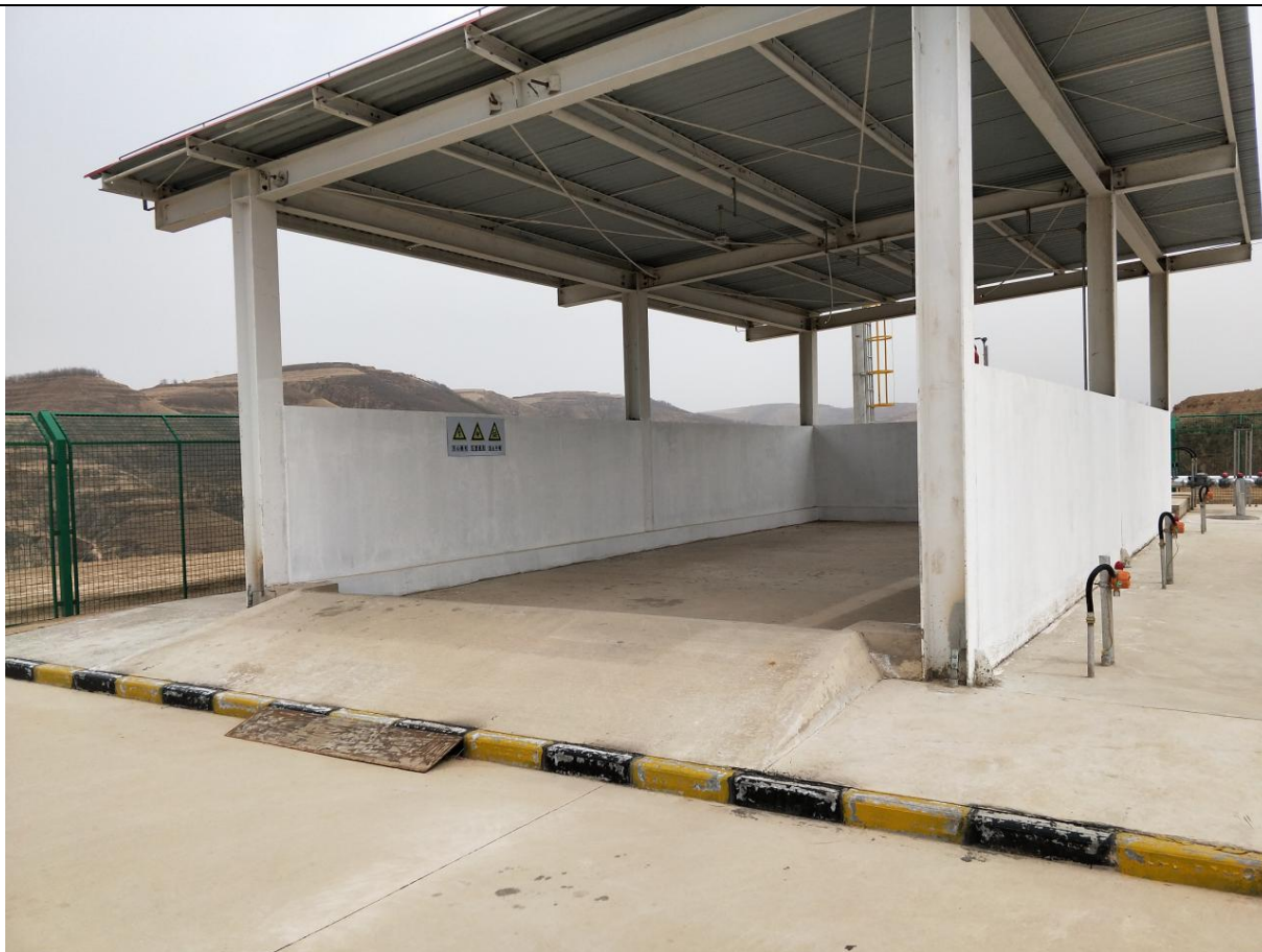
图 4-9 危废及固废暂存场
