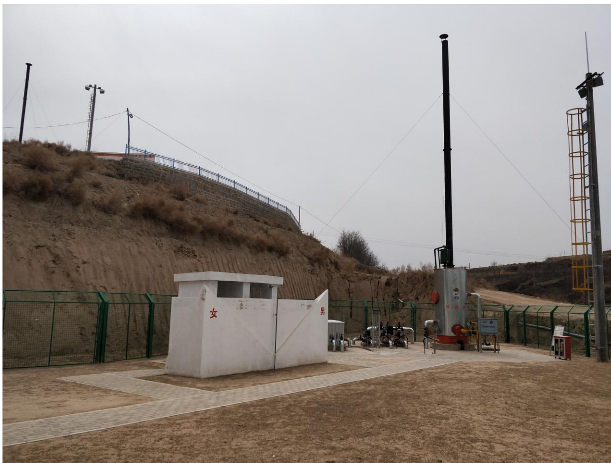
图 4-1 加热炉 15m 排气筒及早厕
