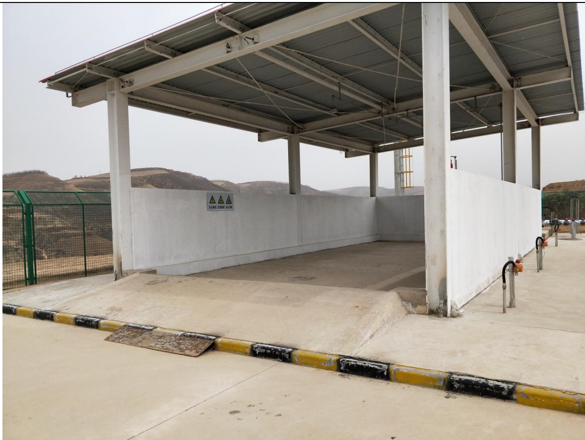
图 4-4 半封闭式污泥及过滤危废堆放棚
