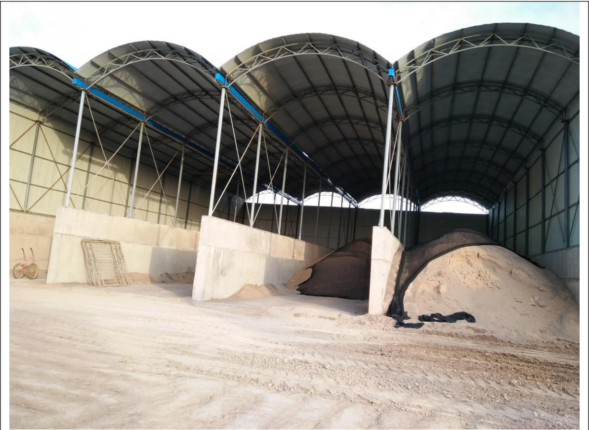
半封闭砂石堆场
