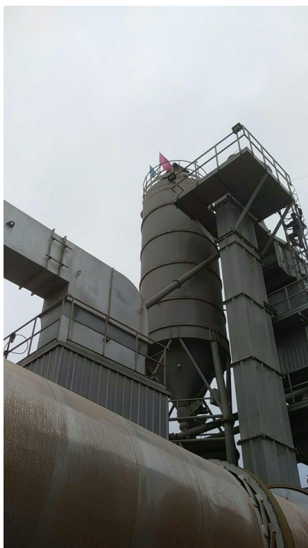
矿粉筒仓（顶部安装滤筒除尘器）
