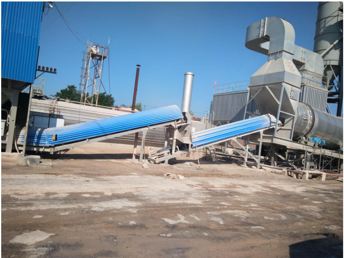
砂石输送皮带（采取全封闭）
