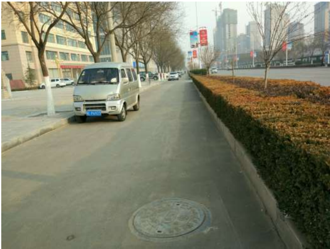
路面恢复（来远路污水管道）
