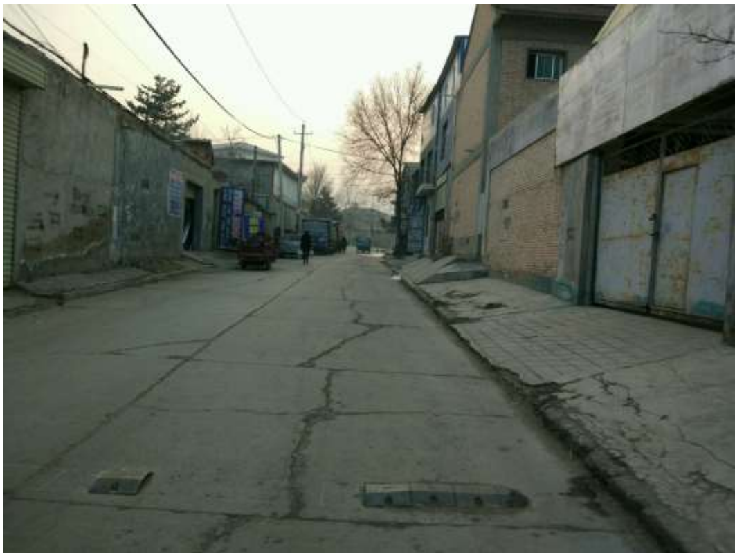
路面恢复（大岔河东岸污水管道）
