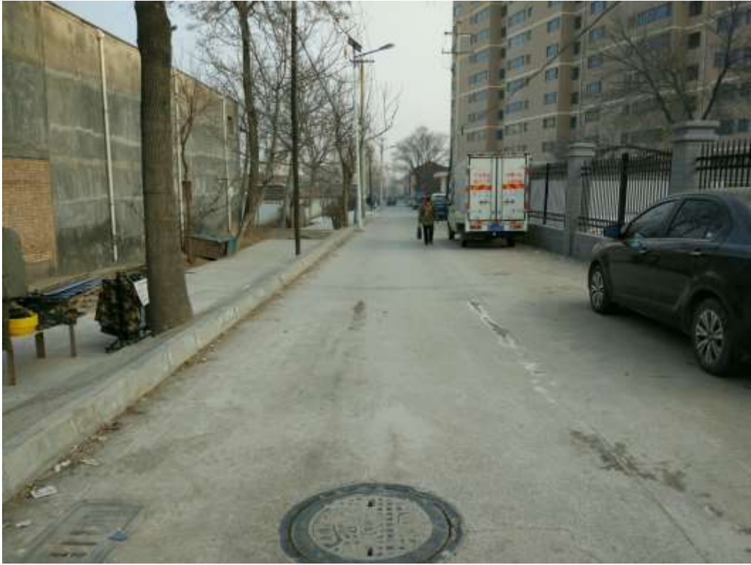
路面恢复（房管处北侧道路污水管道）
