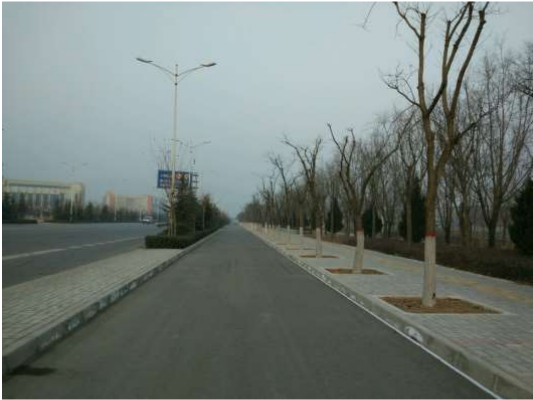
路面恢复（大岔河桥头以北污水管道）
