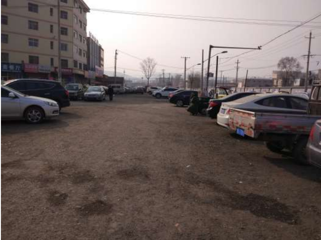
路面恢复（宝塔路污水管道）
