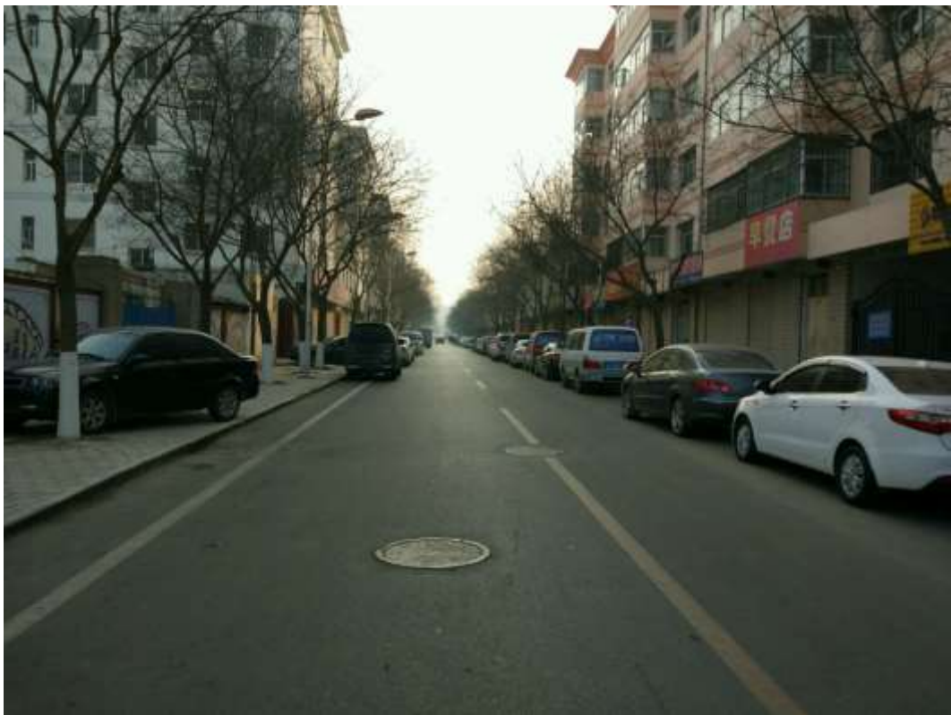
路面恢复（华明路污水管道）
