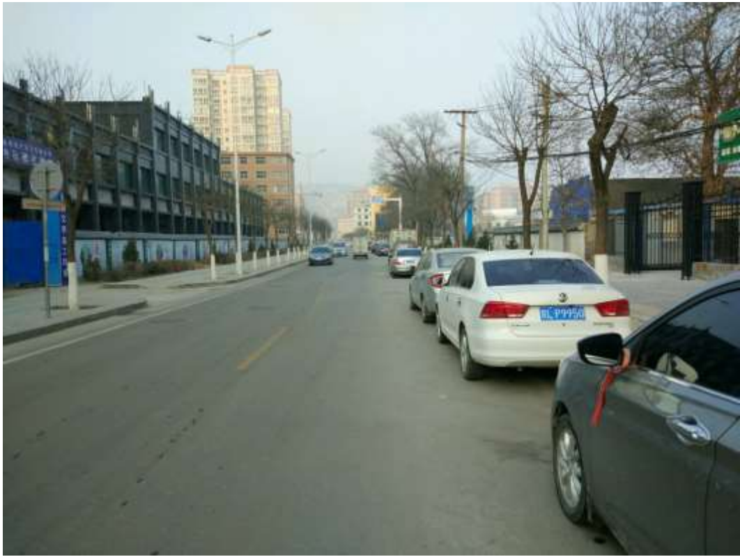
路面恢复（汽车西站消防队）
