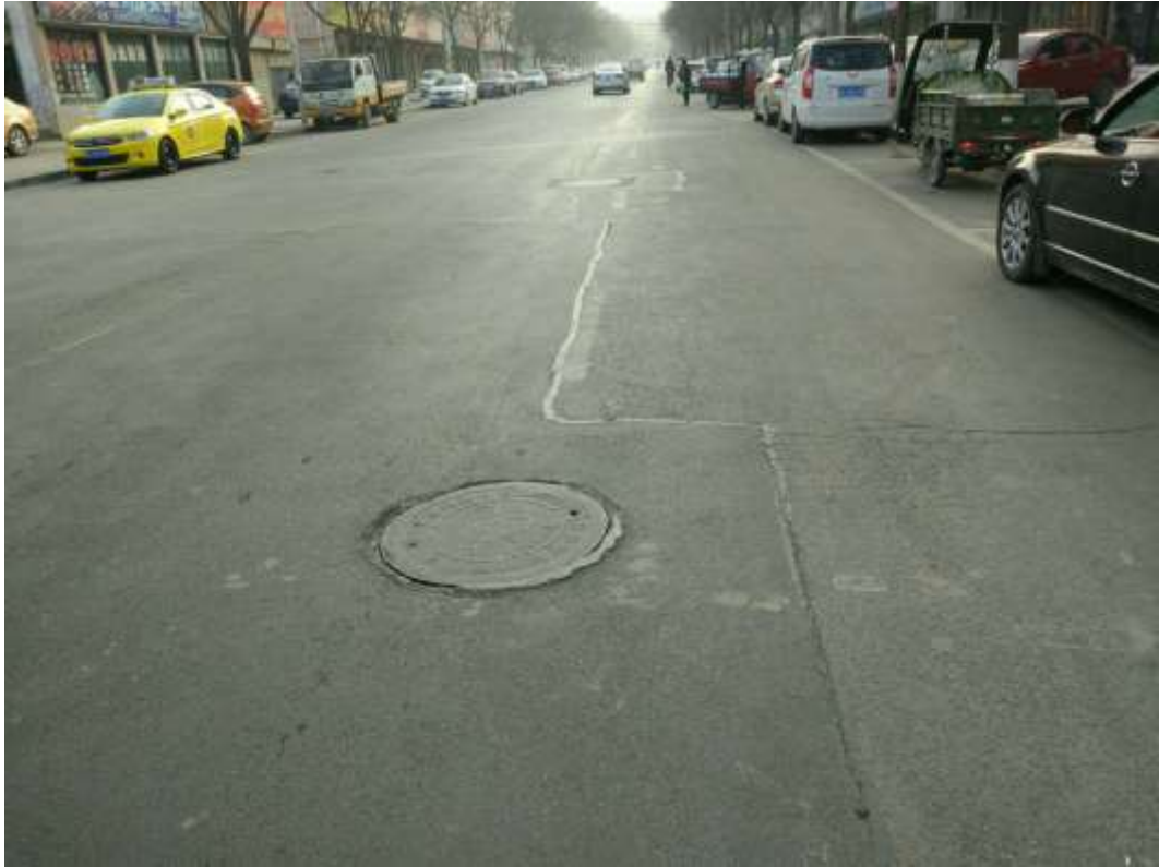
路面恢复（果园路污水管道）
